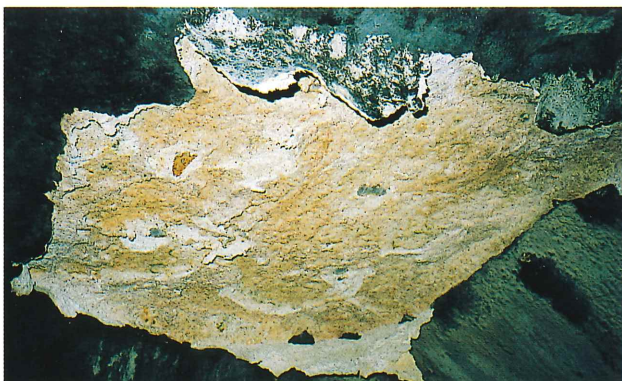
■PSライニング施工前の状況。 タールエポキシ樹脂が著しく劣化(経過7年)
