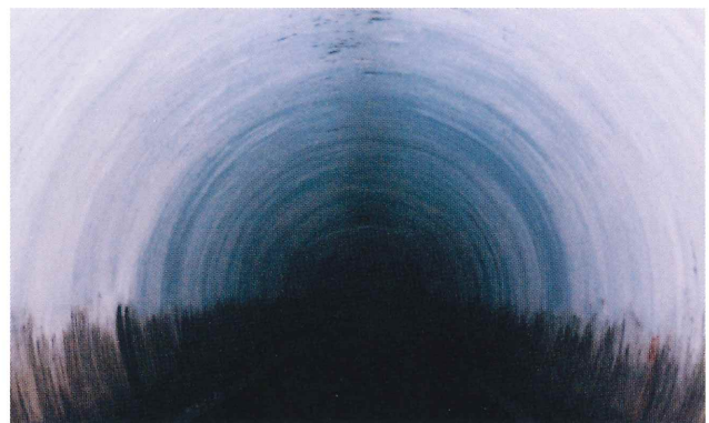
■左写真の劣化部分を撤去し、PSライニングを施工して6年経過後の状況。同じ腐食環境でも、耐久年数が格段に長いことが判ります。
