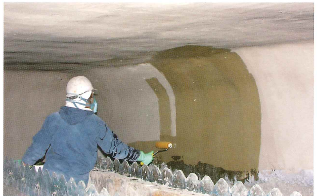
⑥ プライマー塗布状況 (NSUプライマー)
