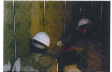
▲ PSシートの取付け
