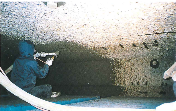
③ 断面修復工
