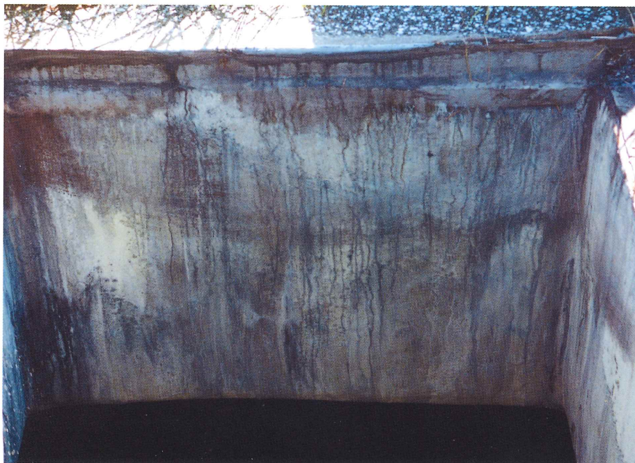
■PSライニング工法5年経過(変状なし)
