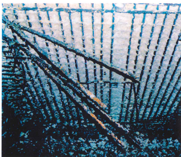
■下水道施設コンクリートの劣化 供用24年でかぶりコンクリートが12cm欠落し、鉄筋が切れている状態
