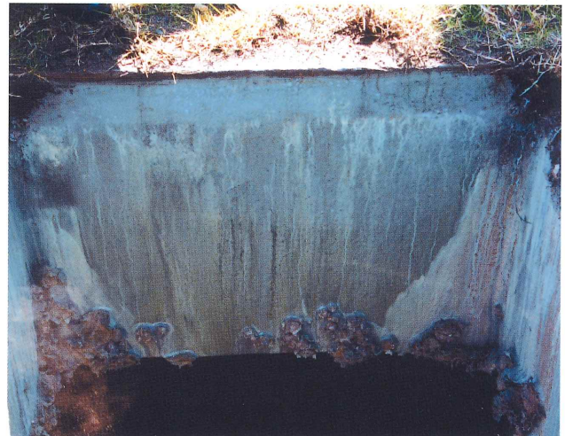
■耐酸性に優れたビニルエステル樹脂を使用しても、再劣化の起こった事例。5年経過(湿潤面接着性が低いのに加えて、出隅の処理が悪い)
