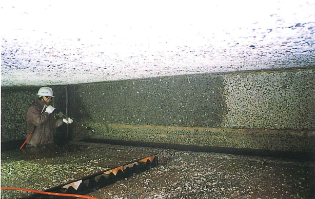
② 下地処理工
