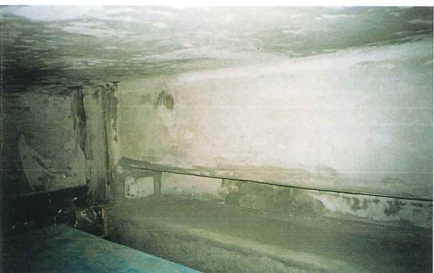
④ 断面修復完了
