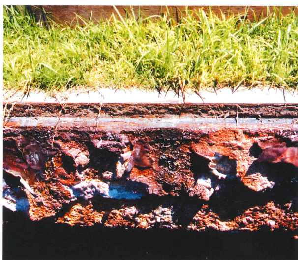
■エポキシ樹脂の再劣化状況 施工後5年経過
